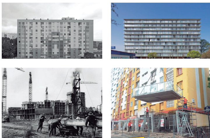
Fig. 3. Arriba izq. Cité du Grand Parc, Burdeos, fachada original del bloque antes de la adaptación. Arriba der. Misma fachada tras la adaptación de Lacaton & Vassal, Druot y Hutin. Abajo izq. Proceso de construcción hacia 1950. Abajo der. Proceso de adaptación hacia 2016. Fuentes: Lacaton & Vassal y Archives Sud Ouest.
