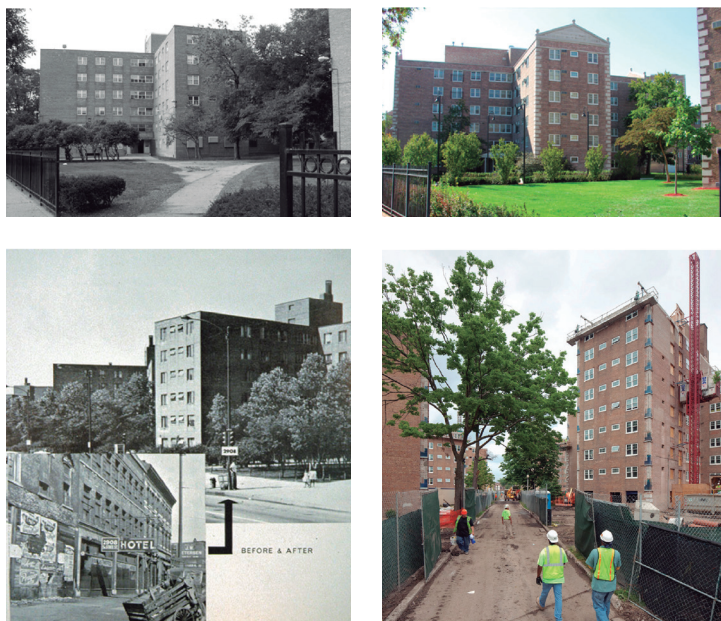
Fig. 10. Arriba izq. Vista original del distrito Dearborn Homes en Chicago.
