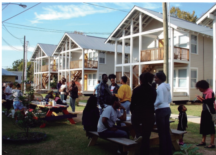
Fig. 10. Viviendas en la calle Division construidas por Row Houses Community Development Corporation (2004). Imagen cortesía de PRH.
