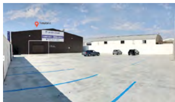
Fig. 7. Fachada principal del Tanatorio Crematorio Luis Iglesias, Rábade (Lugo). Google Street View.
