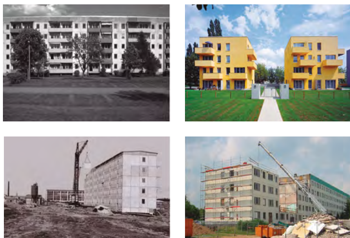
Fig. 5. Arriba izq. Fachada del bloque original de Leinefelde Südstadt, todos los bloques iguales. Arriba der. El mismo bloque original adaptado en ocho villas por Stefan Forster Architekten. Abajo izq. Proceso de construcción del barrio. Abajo der. Proceso de adaptación hacia 2004. Fuentes: Stefan Forster Architekten y Wohnungsbau und Verwaltungs GmbH Leinefelde.
