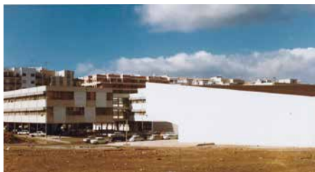
Fig. 15. Pabellón sur de docencia e investigación y aula magna. Testero. Foto fin de obra. Archivo AL-M.
