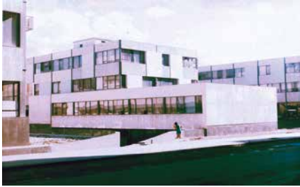
Fig. 17. Pabellones de la sección de geológicas. Foto fin de obra. Archivo AL-M.
