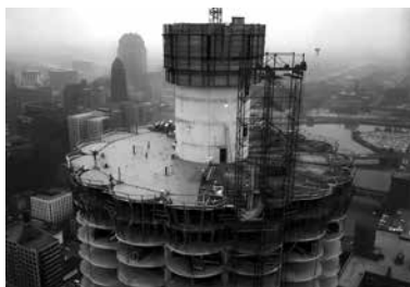
Fig. 6. Piso piloto de uno de los apartamentos. Chicago History Museum. Fotografía Hedrich-Blessing. HB-23215-B7.
